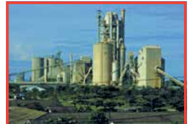
Kompleks Pabrik Tarjun, Kotabaru, Kalimantan Selatan Pabrik ke-12
